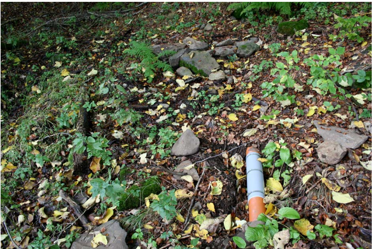
Abb.: Verrohrung im Bereich der Bauersberg-Quelle 07.
