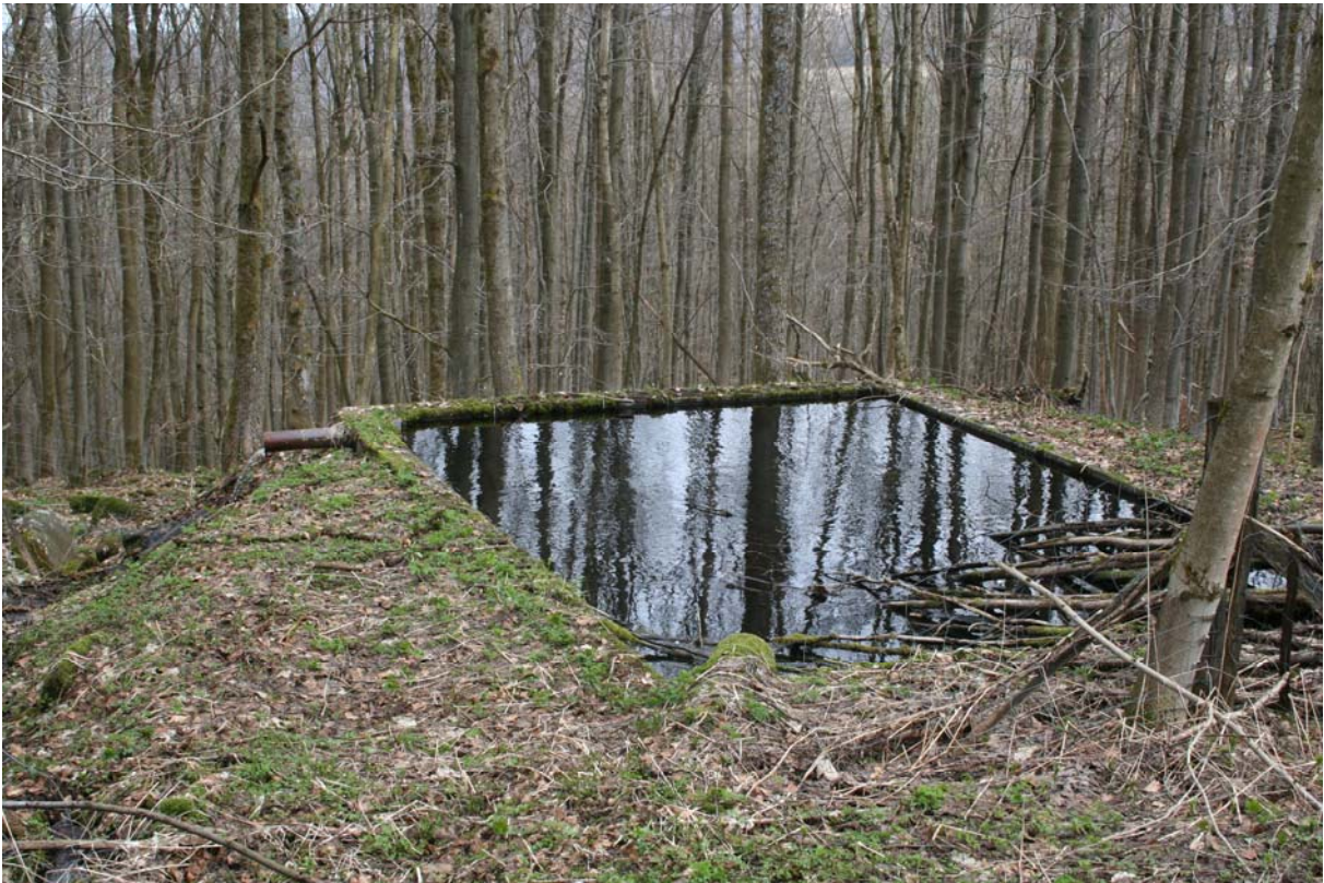
Abb.: Betoniertes Wasserbecken unterhalb der Schwarzwaldquelle 179
