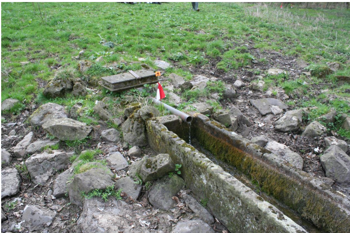
Abb.: Die als Viehtränke gefasste Battensteinquelle 3
