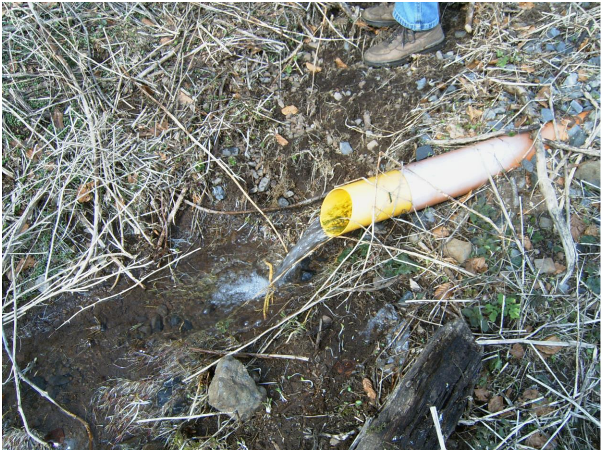
Abb.: Drainagerohr in der Steinkopf Hutequelle 11
