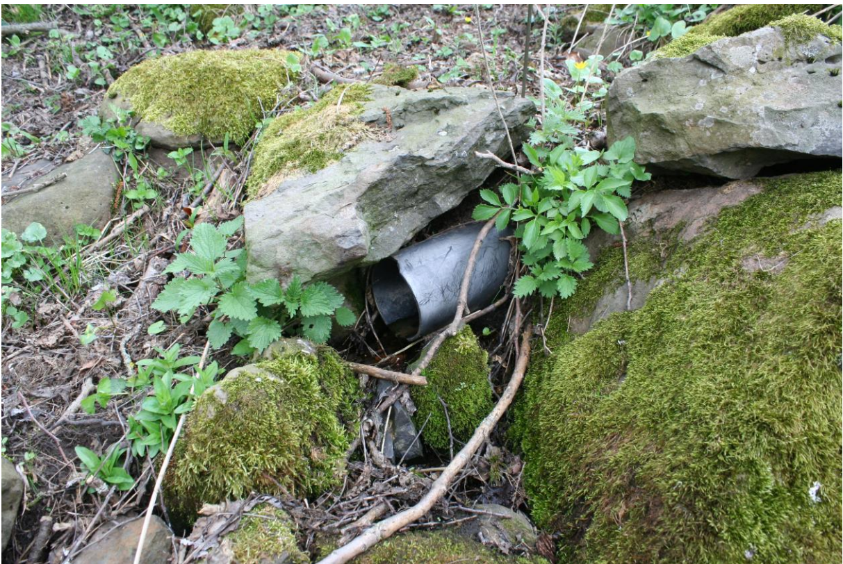
Abb.: Verrohrung in der Bornbergquelle 21
