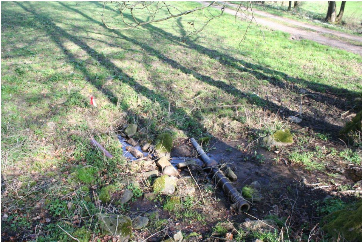
Abb.: Alte Drainagerohre in der Brückenhutquelle 31
